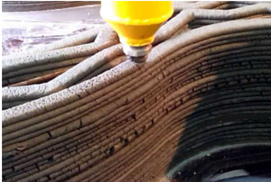
Máy in 3D thiết kế kết cấu bê tông
